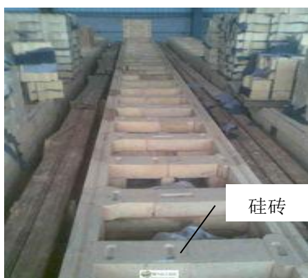
图1 采用高导热硅砖的焦炉炭化室
